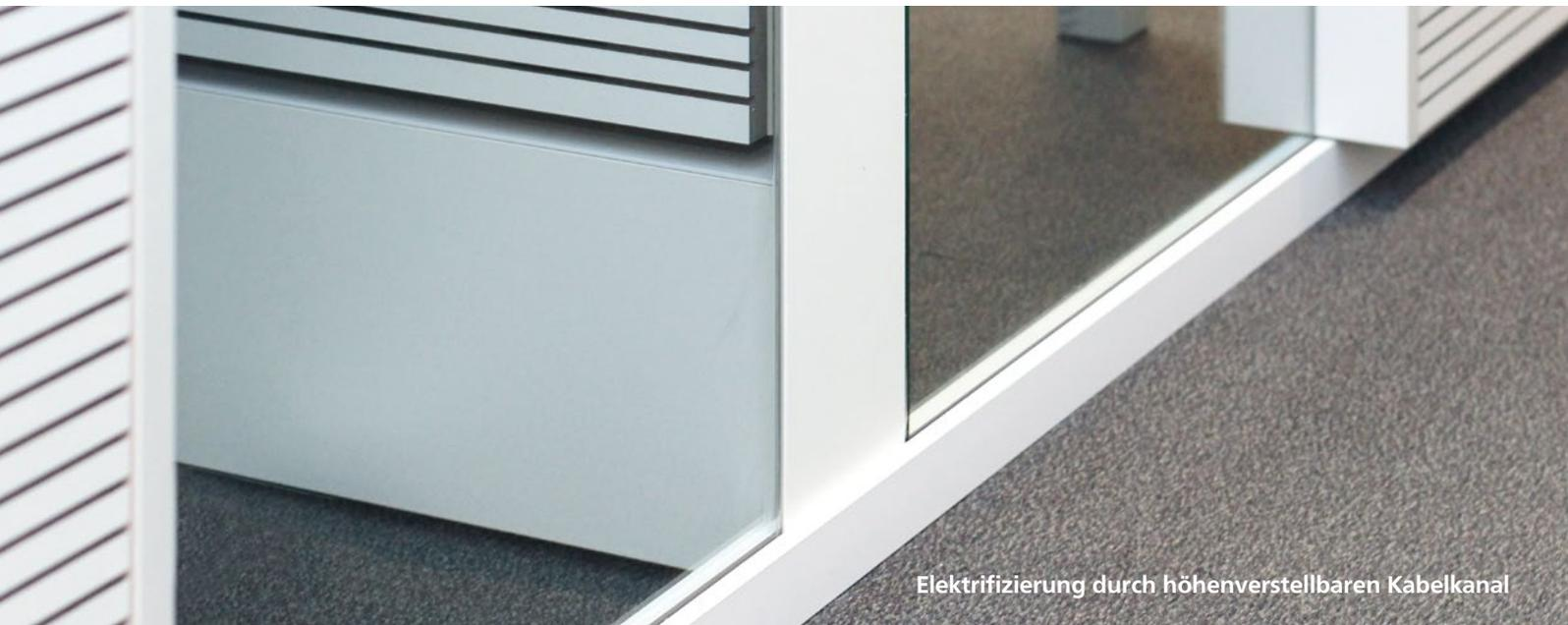
Elektrifizierung durch höhenverstellbaren Kabelkanal
